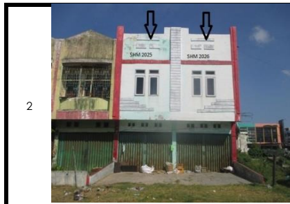
2 Ruko, Komplek Terminal APK, Pintu ke 1 dari kanan, Kelurahan Kampung Baru, Kecamatan Baiturrahman - Banda Aceh
