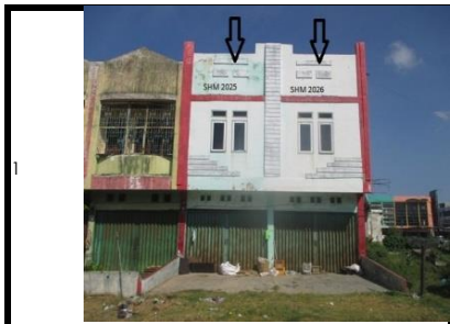
1 Ruko, Komplek Terminal APK, Pintu ke 2 dari kanan, Kelurahan Kampung Baru, Kecamatan Baiturrahman - Banda Aceh
